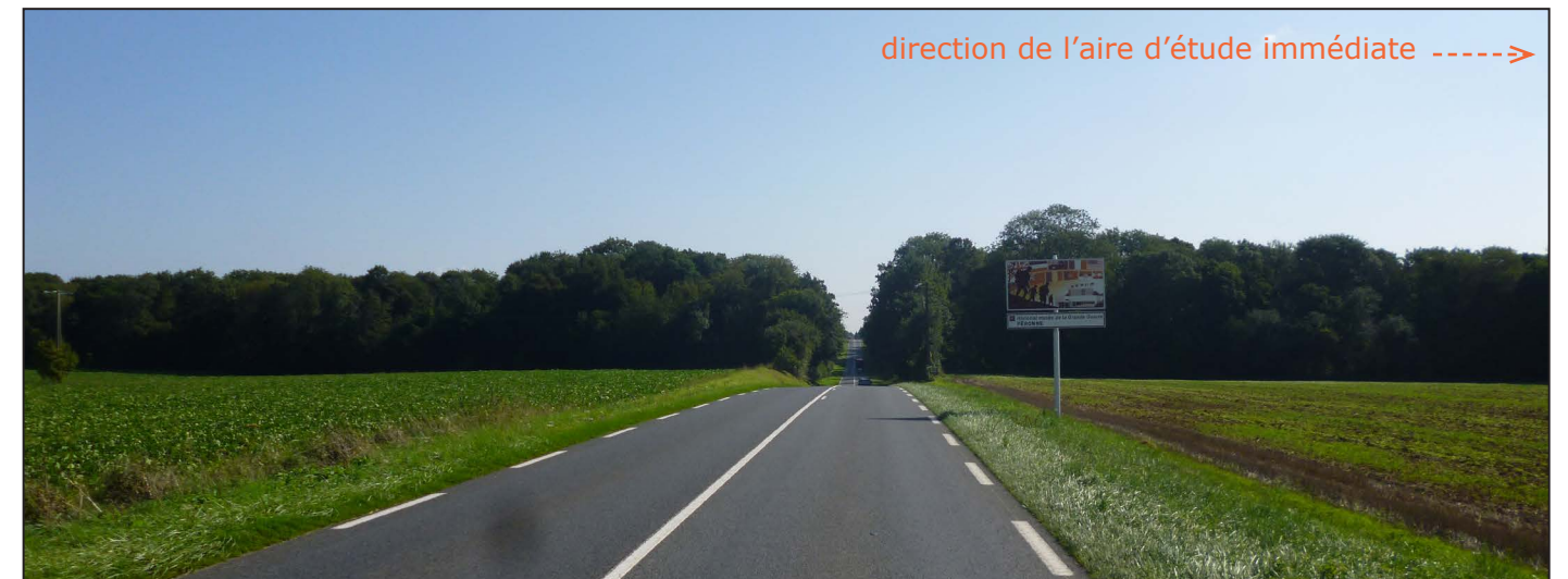
25- Vue sur la D1029 - Chaussée Brunehaut - ancienne voie romaine limite nord de l'aire d'étude éloignée.
